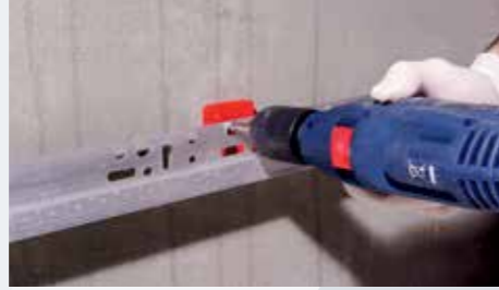
Subasman profilinin dübel ile monte edilmesi.
