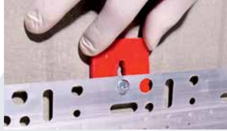
Subasman profilinin plastik takozlarla dengelenmesi.
