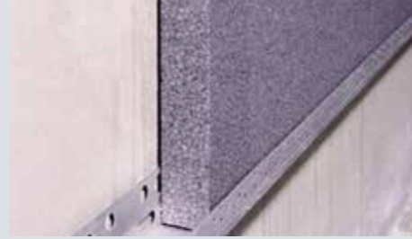
Levhaların subasman profiline yerleştirilmesi.
